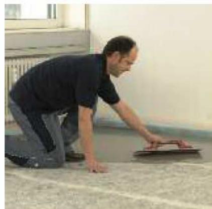
Nanášanie tenkého poteru UZIN NC 195
