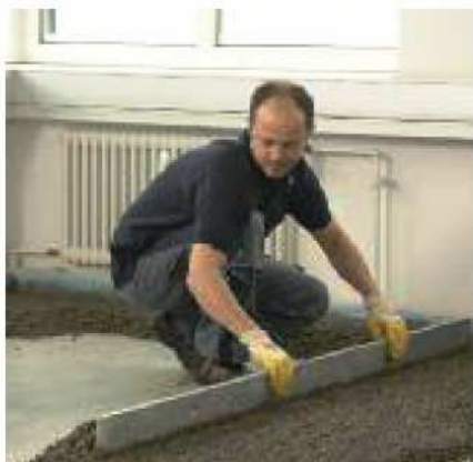
Kladenie ľahkej vyrovnávacej malty UZIN NC 194 Turbo
