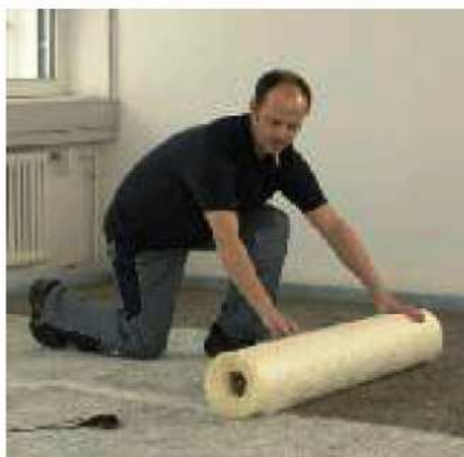
Položenie renovačného rúna UZIN RR 201
